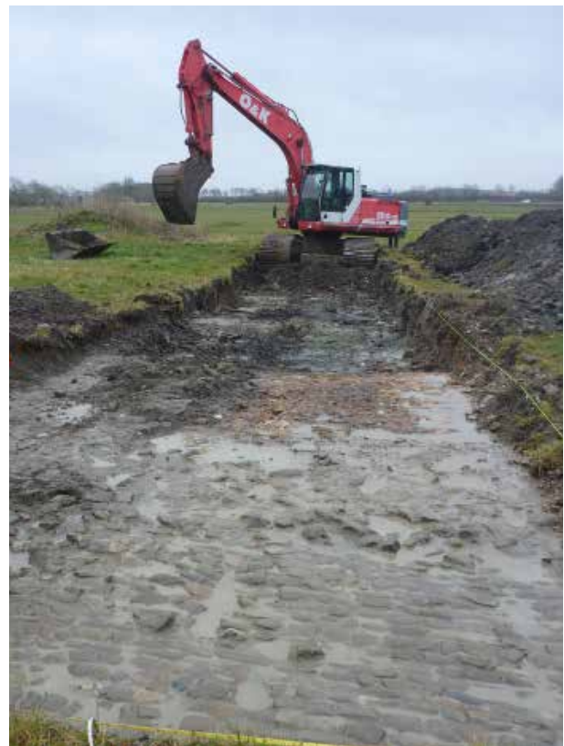
Fig. 22 Overzicht werkput 6 met de resten van een kasseien bestrating (binnenerf) van de boerderij Thuynenburg
