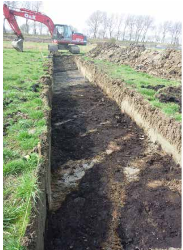
Fig. 30 Overzicht WP 2 met intact Hollandveen en inspoelingscheuren op de voorgrond en moertering in de achtergrond.
